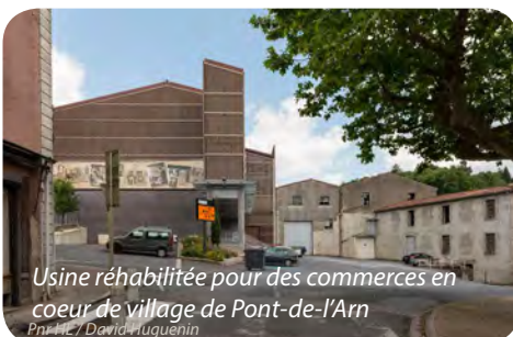
Bâtiment industriel avec toiture en panneaux photovoltaïque Pnr HL / E. Engel
