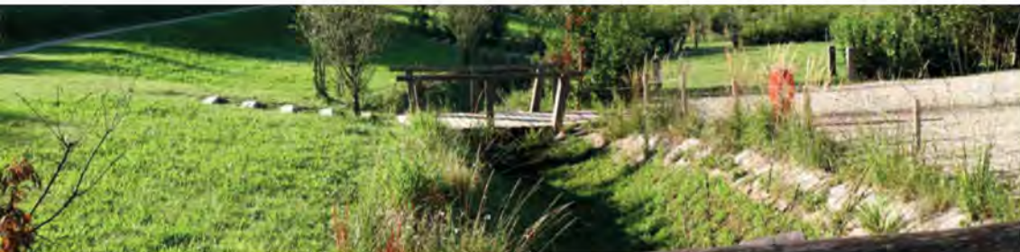
Exemple d'une noue paysagère servant de fossé d'écoulement des eaux pluviales (atelier de Lunas).
