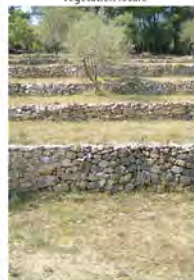
Terrassement en restanques
