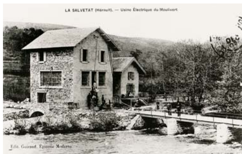
Usine électrique de Moulinvert à la Salvetat sur Agout
