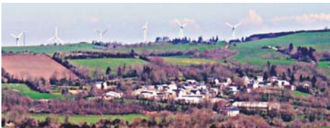
Village de Plos et Parc éolien du puèch de Cambert (Commune de Barre)
