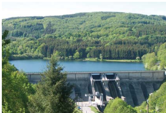
Barrage de la Raviège
