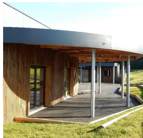
Ecole « en bois » d'Aiguefonde source : https://aiguefonde.fr/dscn2508/
